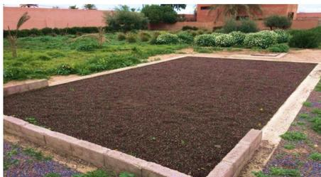
Dans notre zone de production la plus au sud (Dakhla), nous avons mis en place trois stations de traitement pour traiter les eaux usées des zones d'habitation des travailleurs, avec un processus de traitement adapté à l'environnement rural, en utilisant des roseaux et des briques.
